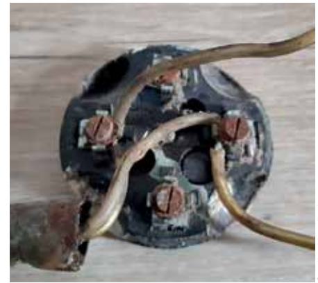
12 Ungünstigster Fall (Worst Case): Schraubverbindungen in einer der Verteilerdosen in Hohen Neuendorf
