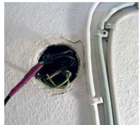
13 Untersuchung der Verteilerdose mit Kupferleitungen in der Münchener Wohnung vor Ort
